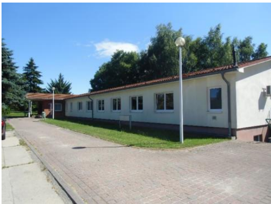
Ansicht Straßenseite / Westseite des Gebäudes
