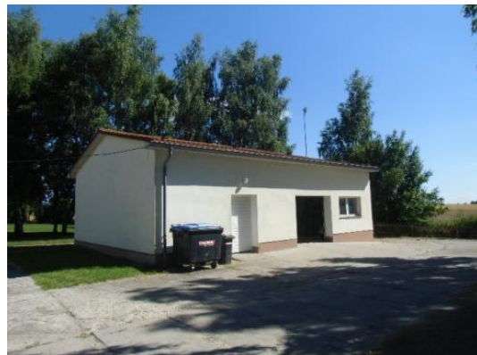
Ansicht Lagergebäude mit Garage
