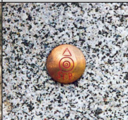
SFP Messingbolzen Ø 3 cm
